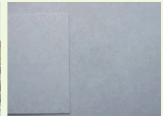
写真・4 施工後の見本版との照合
