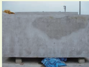
写真・2 施工前のPCの状況
