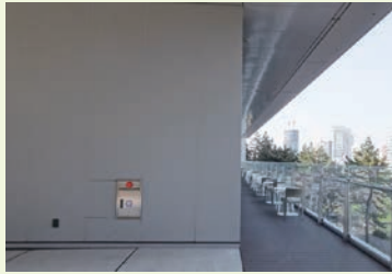
写真・6 ECP面の塗装表情の近景
