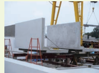
写真・3 施工前 (右)・施工後 (左)
